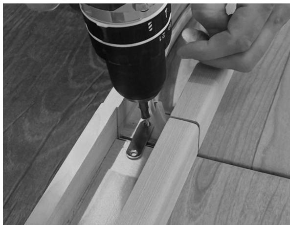
Verbinden Sie die beiden Bodenelemente, indem Sie die Elemente zusammenschieben und mittels der metallenen Verbindungsleisten fixieren.
