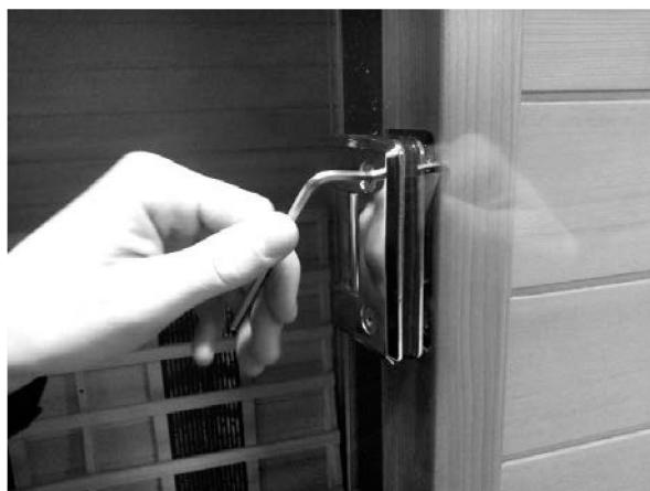
Avec une clé hexagonale (Inbus) de 4 mm, ajustez les vis des charnières de la porte en verre. Au besoin, vous pourrez toujours a posteriori réajuster la position de la porte en verre en jouant sur ces vis.
