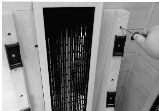
Vissez (3 vis chacune) les barres en bois avec les fixations pour les dossiers flexibles directement à côté des rails de guidage, pour que leur bord supérieur soit horizontal et sur la même ligne que ces derniers. La distance entre les deux barres en bois doit être d'environ 32 cm.
