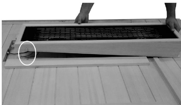
Montez maintenant le projecteur dorsal. Pour cela, posez le panneau arrière sur le sol ou sur une surface plane et stable. Placez le projecteur dorsal entre les deux rails de guidage. Les deux tenons doivent se glisser dans les renflements prévus (en ovale dans l'illustration) des rails de guidage.
