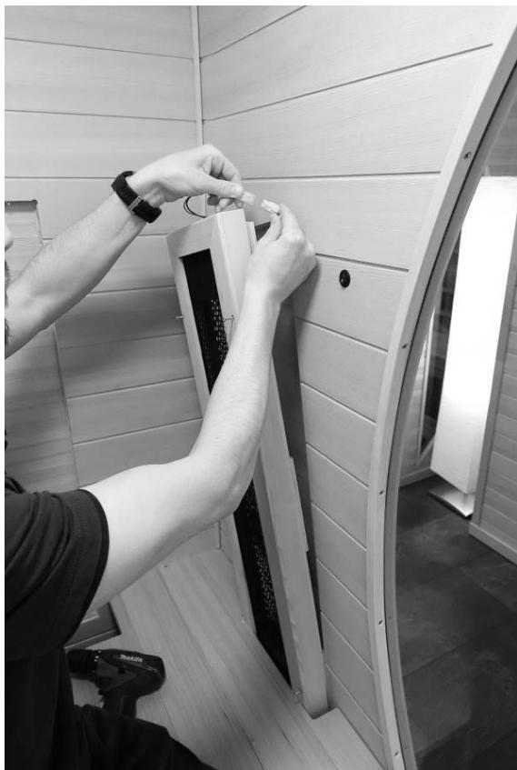
Placez les rayonneurs infrarouges dans les renflements des parois latérales gauche et droit et reliez les connecteurs entre eux.
