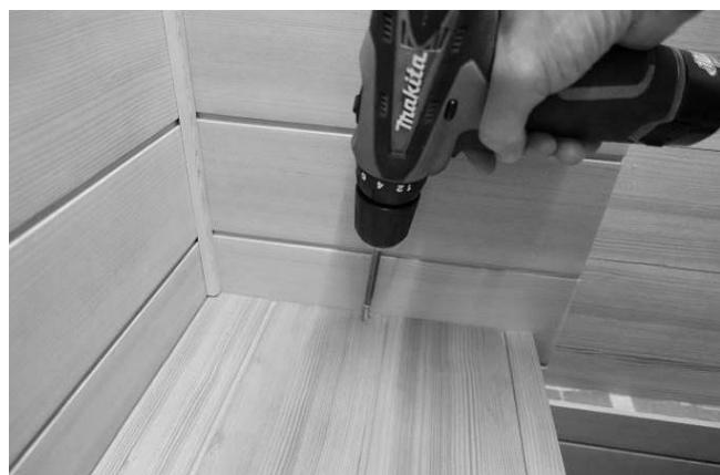
Vissez le banc sur le rebord de la paroi arrière à l'aide de **2 vis de 30 mm.**
