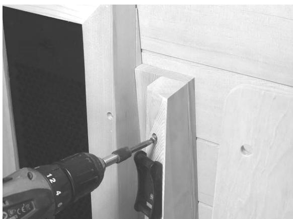
Vissez les barres en bois avec les supports pour les dossiers flexibles directement **sur** l'adaptateur, de manière à ce qu'elles soient à plat avec eux en haut et sur les côtés (**3 vis de 50 mm pour chaque**).
