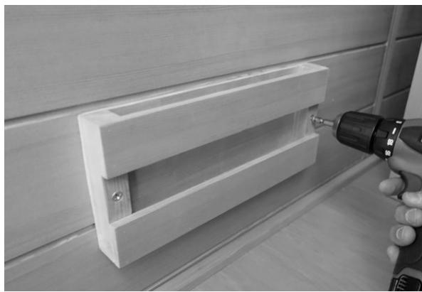
Le porte-revues est monté sur la paroi de la cabine avec **2 vis de 40 mm**, de préférence sur la moitié inférieure droite de la paroi latérale (vue d'une position assise). Nous recommandons de pré-percer les trous pour éviter les fissures.
