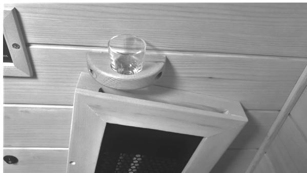
Le support avec le bol en verre doit être monté au milieu au-dessus d'un rayonneur infrarouge (**2 vis de 40 mm**). La distance entre le cadre du rayonneur et le support doit être d'au moins 2 cm. Nous recommandons de pré-percer les trous avec une mèche à bois de 2 à 3 mm.
