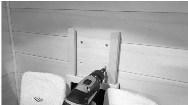
Positionnez la planche de l'appui-tête au milieu, au-dessus du rayonneur dorsal entre les dossiers ergonomiques flexibles et vissez-la à la paroi arrière avec les vis fournies (**4 de 30 mm**). Couvrez ensuite les trous avec l'un des caches fournis et glissez l'appui-tête dans les rails de guidage.
