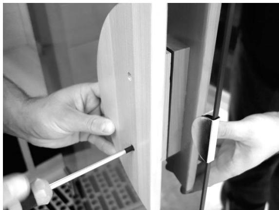
Installez la poignée de porte. Pour ce faire, insérez une vis (**2 de 50 mm métrique**) dans le trou supérieur de la poignée intérieure et dans le trou supérieur de la porte en verre. Vissez maintenant la poignée extérieure. Procédez de la même manière avec la deuxième vis.
