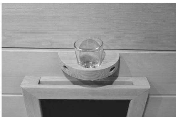
Le support avec la coupelle en verre doit être monté au centre au-dessus d'un émetteur de chaleur profonde (**2 vis de 40 mm**). La distance entre le cadre de l'émetteur et le support doit être d'au moins 2 cm. Nous recommandons de percer les trous avec une mèche à bois de 3 mm. pré-percer.
