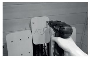
Placez l'appuie-tête au milieu audessus du projecteur dorsal entre les dossiers ergonomiques flexibles et fixez-le sur le panneau arrière avec les vis livrées (60 mm). Cachez ensuite les trous avec les caches livrés.
