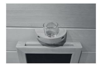
Le support avec la coupelle en verre devrait être monté au milieu et au-dessus d'un projecteur chaleur profonde (avec 2 vis 40 mm). L'écart entre le cadre en acier et le support doit être d'au moins 2 cm. Nous vous conseillons de prépercer les trous avec un foret bois 2-3 mm.
