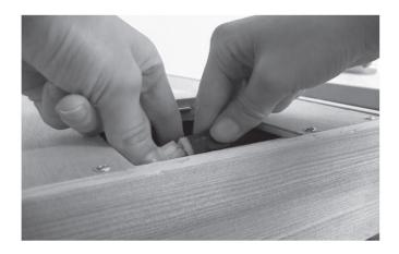
Les prises électriques sont placées dans les ouvertures de maintenance dans la partie supérieure de la cabine infrarouge.
