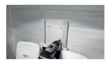
Placez le support de l'appuie-tête au milieu au-dessus du projecteur dorsal entre les dossiers ergonomiques flexibles et fixez-le sur le panneau arrière avec les vis livrées (3 x 30 mm, 4 pour le modèle PH1). Cachez ensuite les trous avec les caches livrés et glissez l'appuie-tête sur les rails de guidage.
