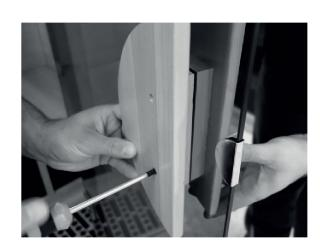
Montage des poignées de la porte. Pour cela, enfoncez une vis (50 mm) au travers du trou supérieur de la poignée intérieure et du trou supérieur de la porte en verre. Vissez maintenant la poignée extérieure. Recommencez avec la seconde vis.
