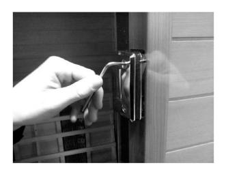
Avec une clé hexagonale (Inbus) de 4 mm, ajustez les vis des charnières de la porte en verre. Au besoin, vous pourrez toujours a posteriori réajuster la position de la porte en verre en jouant sur ces vis.
