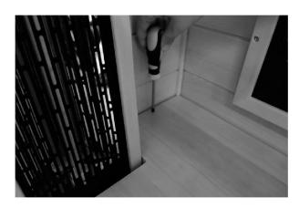
Fixez le banc avec deux vis à la plinthe du panneau arrière.
