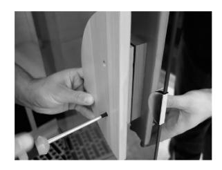
Montage des poignées de la porte. Pour cela, enfoncez une vis au travers du trou supérieur de la poignée intérieure et du trou supérieur de la porte en verre. Vissez maintenant la poignée extérieure. Recommencez avec la seconde vis.
