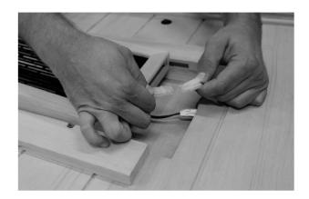
Raccordez les connecteurs enfichables à la partie supérieure du projecteur. Vérifiez que la prise et les câbles sont bien raccordés.
