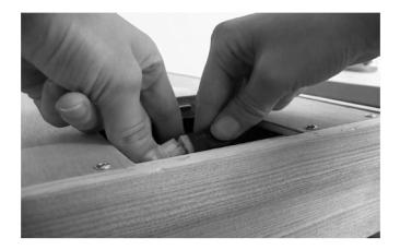
Les prises électriques sont placées dans les ouvertures de maintenance dans la partie supérieure de la cabine infrarouge. Raccordez les connecteurs enfichables. Notez que, dans certaines ouvertures, deux connecteurs enfichables doivent être raccordés.
